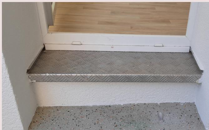
Die Lösung des Problems sehen Sie auf den Fotos unten. Die Betonschwelle wurde herausgesägt, ein neues Fenster eingesetzt und das Ergebnis ist ein fast schwellenloser Austritt auf den Balkon!
